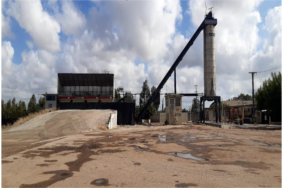
Figura 1: Visão geral dos silos, esteira, misturador, elevador de arrase e tanque de estocagem
