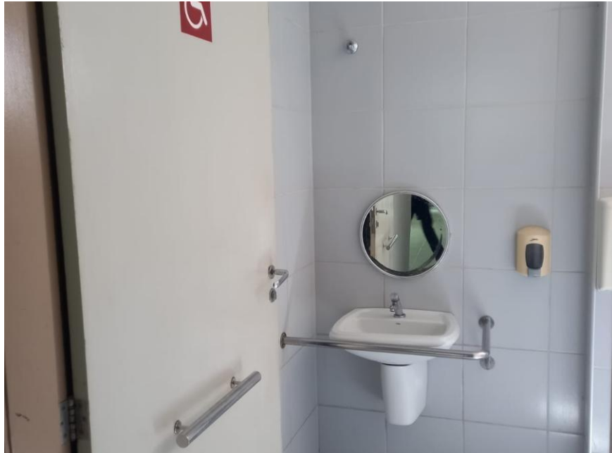
Banheiro acessível – Bloco III.
