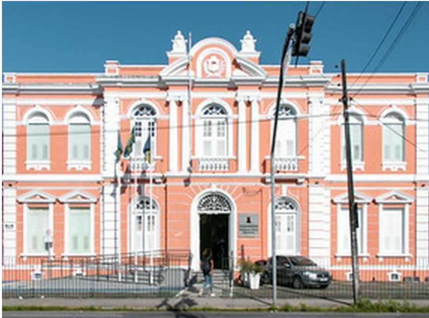
Bloco Didático II – FEAAC/UFC (fachada principal)
